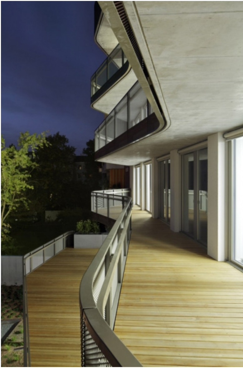
Die vorgelagerten Balkons der Hofseite
